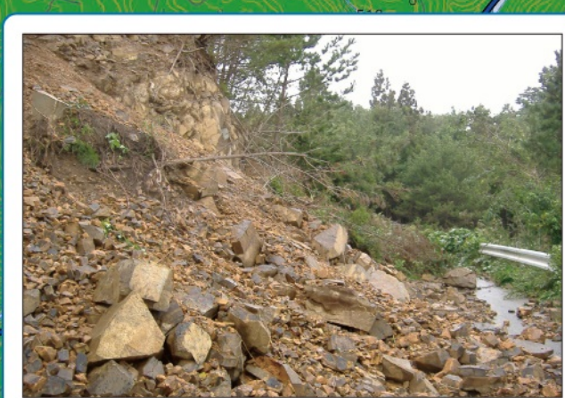
ゆれによる急傾斜地の崩壊 (平成23年、東北地方太平洋沖地震より)
