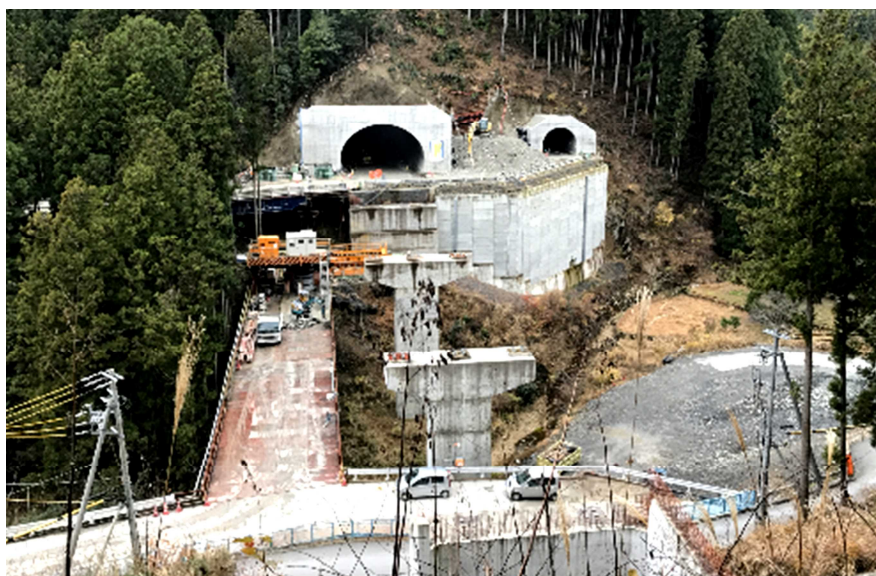
3号トンネル 施工状況
