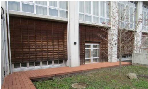
黄柳川小学校は、開校から10年が経過していますが、外壁木部が全面的に防腐剤の色落ち・効果の減少などが見受けられます。快適な学習環境を確保するため、新都市学校施設長寿命化計画（令和4年3月策定）に基づき、木部の外壁塗装工事を実施します。
