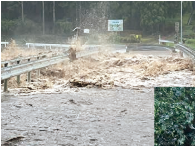
▲只持橋(国道257号) (令和5年)
