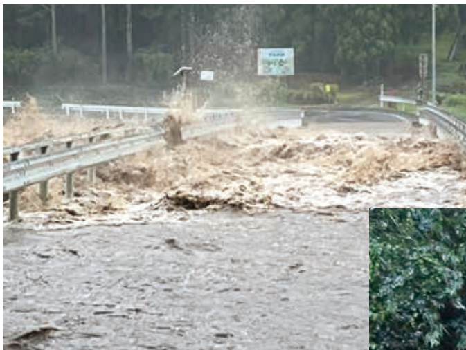
▲只持橋(国道257号) (令和5年)
