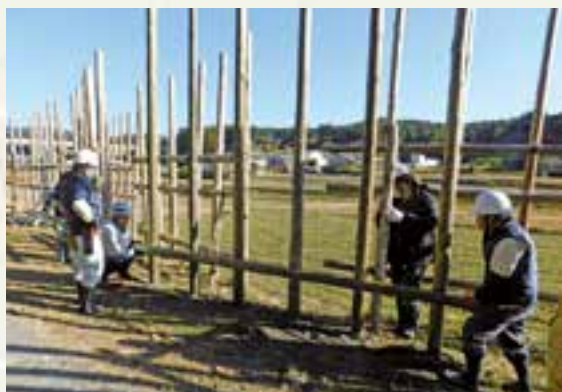
▲馬防柵の改修作業(令和5年12月)
