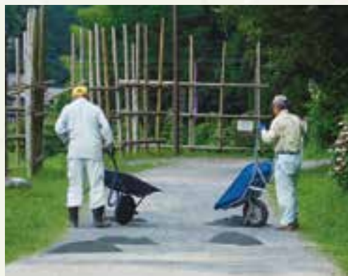
▲道の整備作業(令和5年7月)
