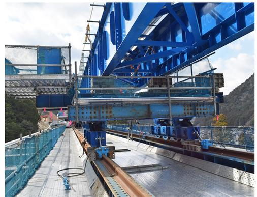
▲「送り出し工法」のレールと装置
