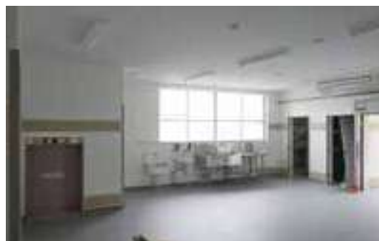
▲東陽小学校(改修後)
