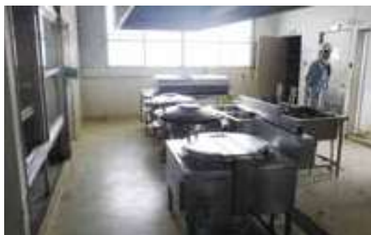
▲東陽小学校(改修前)
