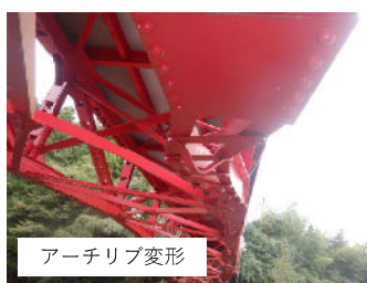
アーチリブ（下フランジ）破断
