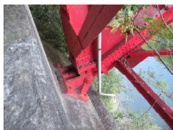
※参考 支点部写真(右岸側)
