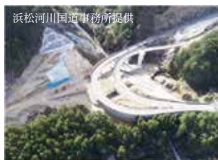
▲工事が進む鳳来峡IC
