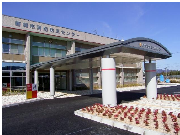
新城市消防防災センター（平井地内）
