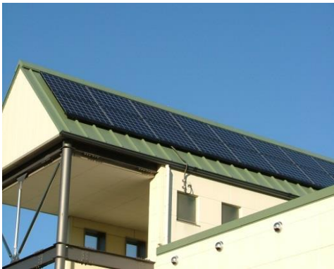
八名こども園の屋根に設置されている太陽光パネル
