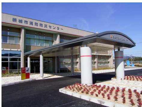
新城市消防防災センター（平井地内）
