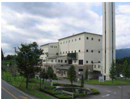
新城市クリーンセンター
