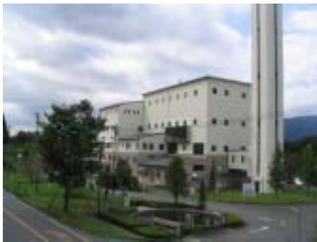
新城市クリーンセンター
