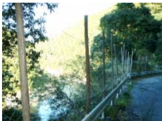
住民が設置した防護ネット（市川地内）
