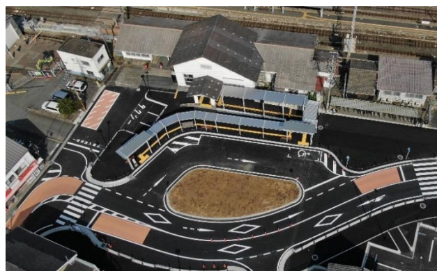
新城駅前広場の暫定整備
