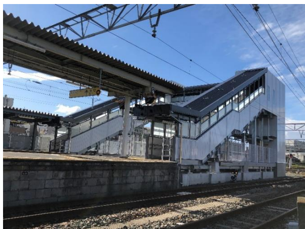
新城駅構内の整備状況
