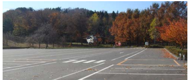
<駐車場の舗装とライン>
