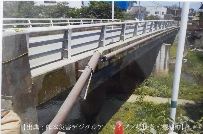
上水管の破損
