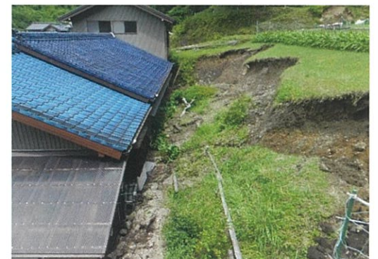
裏山が崩落し土砂で埋まった家屋
