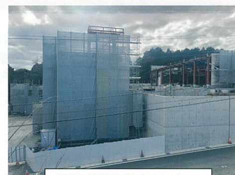
建設が進む給食センター
