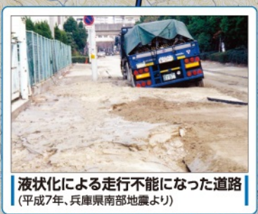
液状化による走行不能になった道路 (平成7年、兵庫県南部地震より)
