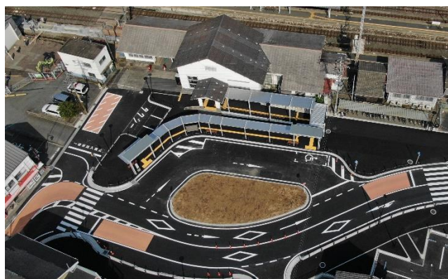
新城駅前広場の暫定整備
