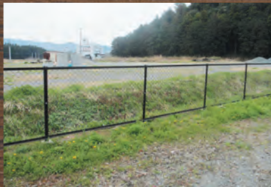
フェンス工事
