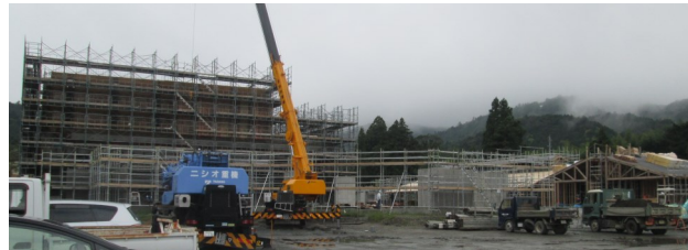
▲山村交流施設建設の様子
