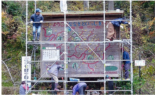
区民で看板屋根の葺き替えをしました。
