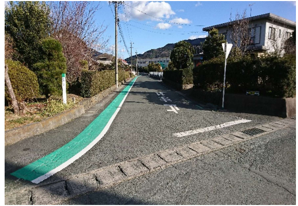
路肩カラー塗装設置
