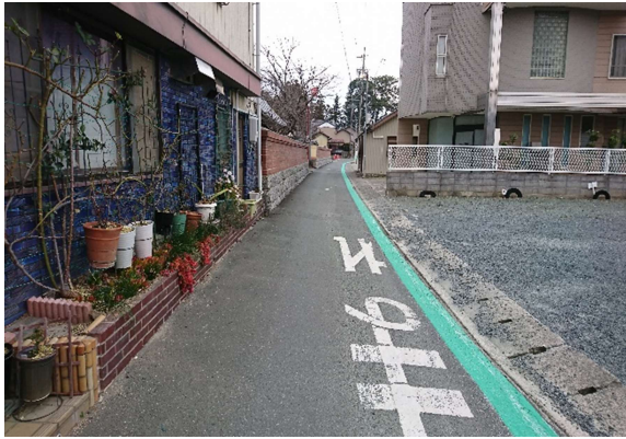
路肩カラー塗装設置
