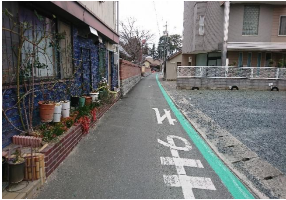
路肩カラー塗装設置
