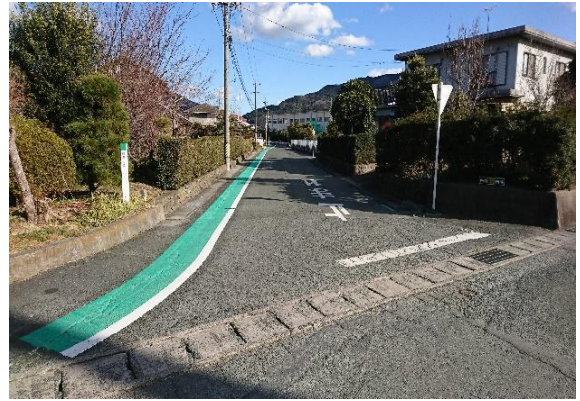
路肩カラー塗装設置
