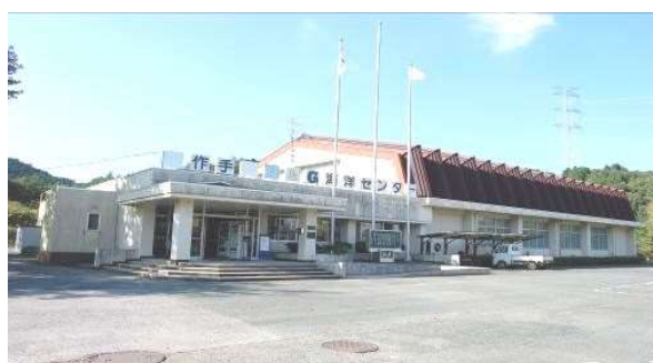
体育館・事務室外観
