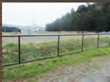
フェンス工事
