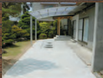
カーポート設置
