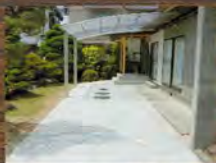
カーポート設置
