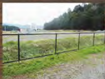
フェンス工事
