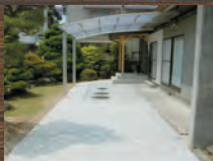
カーポート設置
