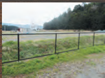
フェンス工事
