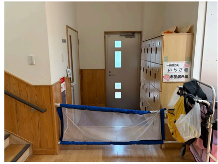
▲図 3.8 出入口の様子
