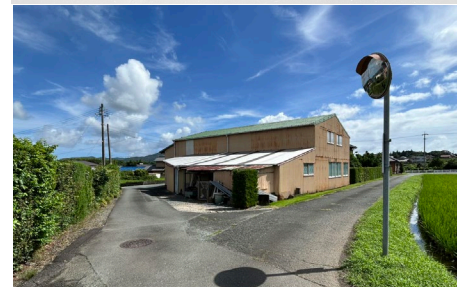
②南東側道路
