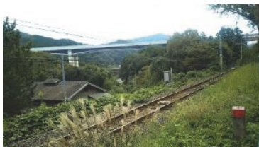
土塁跡 3（北西から）
